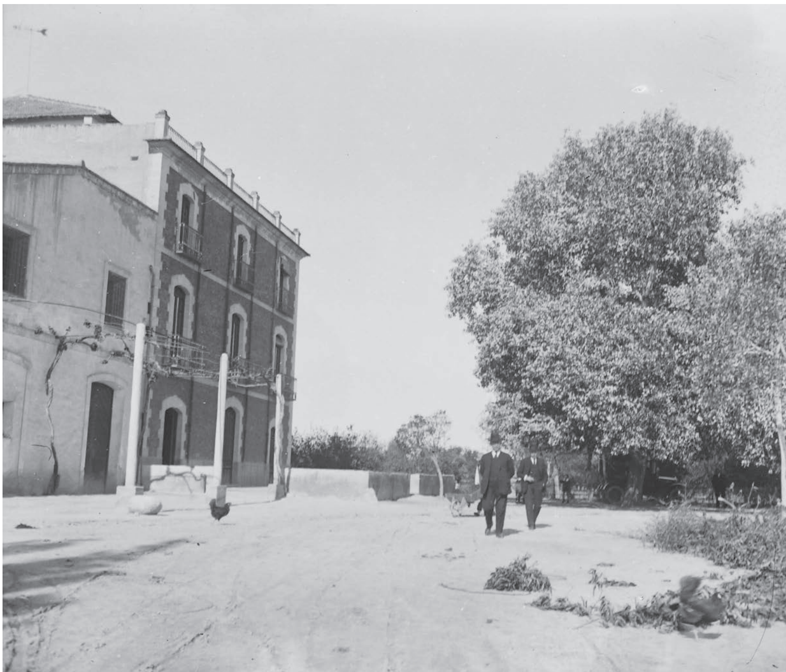
Casa torre junto a la ermita de la Paz, en Alcantarilla. Situada en el paraje de la Voz Negra, una de las zonas de cultivo más antiguas de la Huerta de Murcia.
