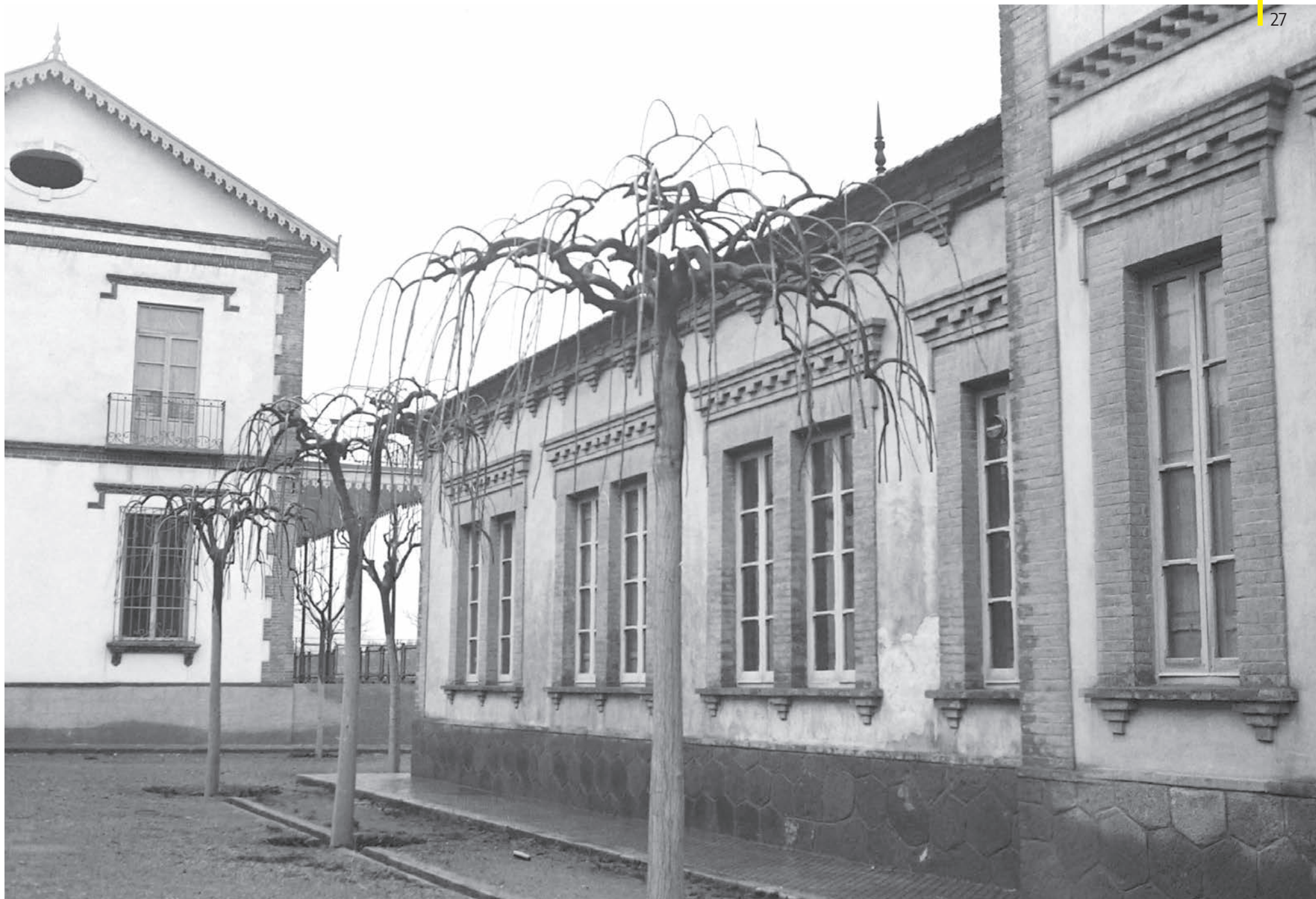
Detalle de la fachada trasera del edificio de oficinas, con ventanas originales de madera.
