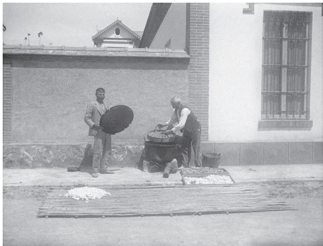
Carga de la caldera.
