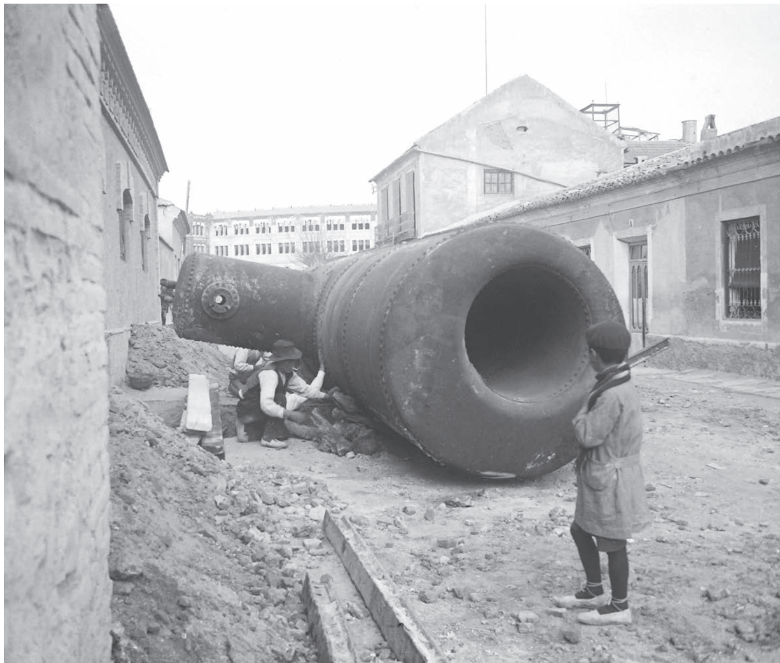
Gran caldera instalada en el ahogadero secante, durante la ampliación de las instalaciones en 1925, con la plaza de toros al fondo.
