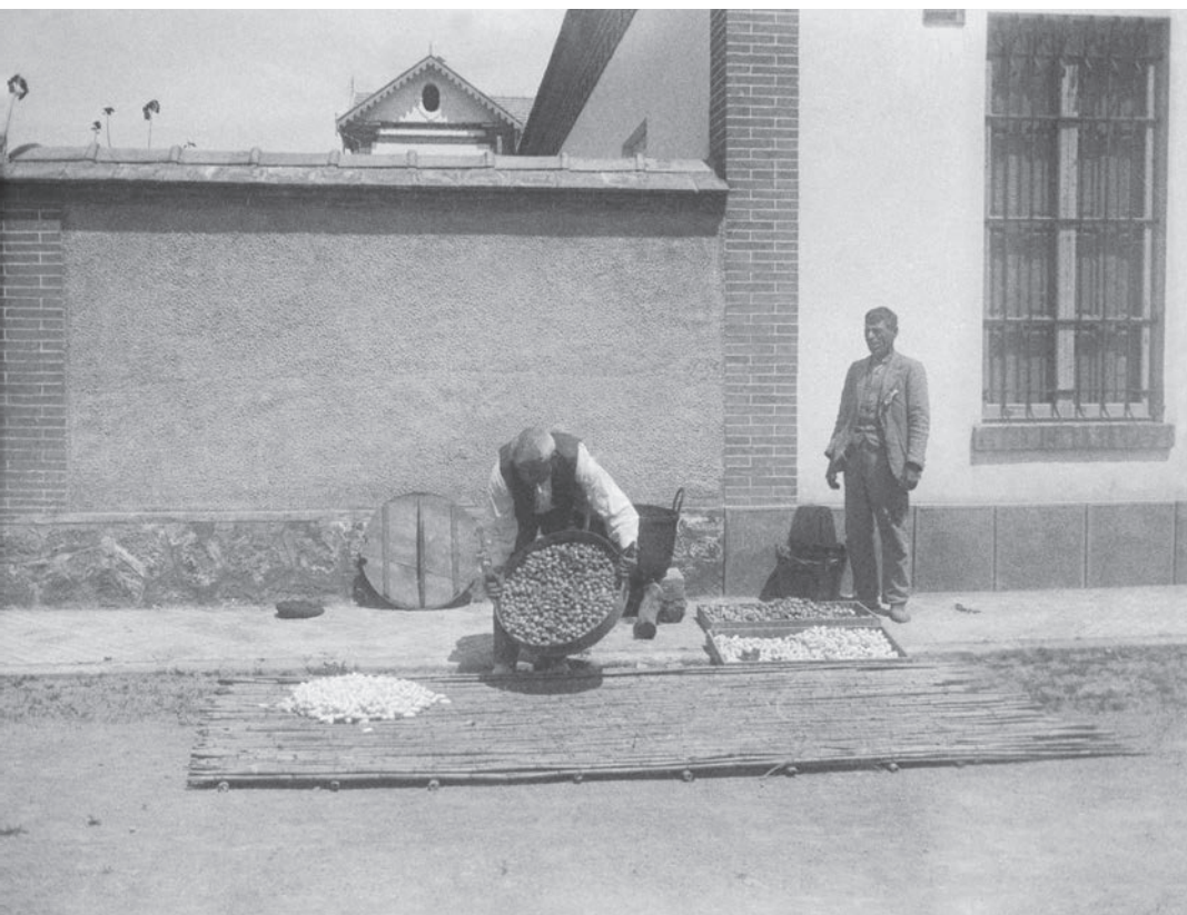
Descarga de la caldera.
