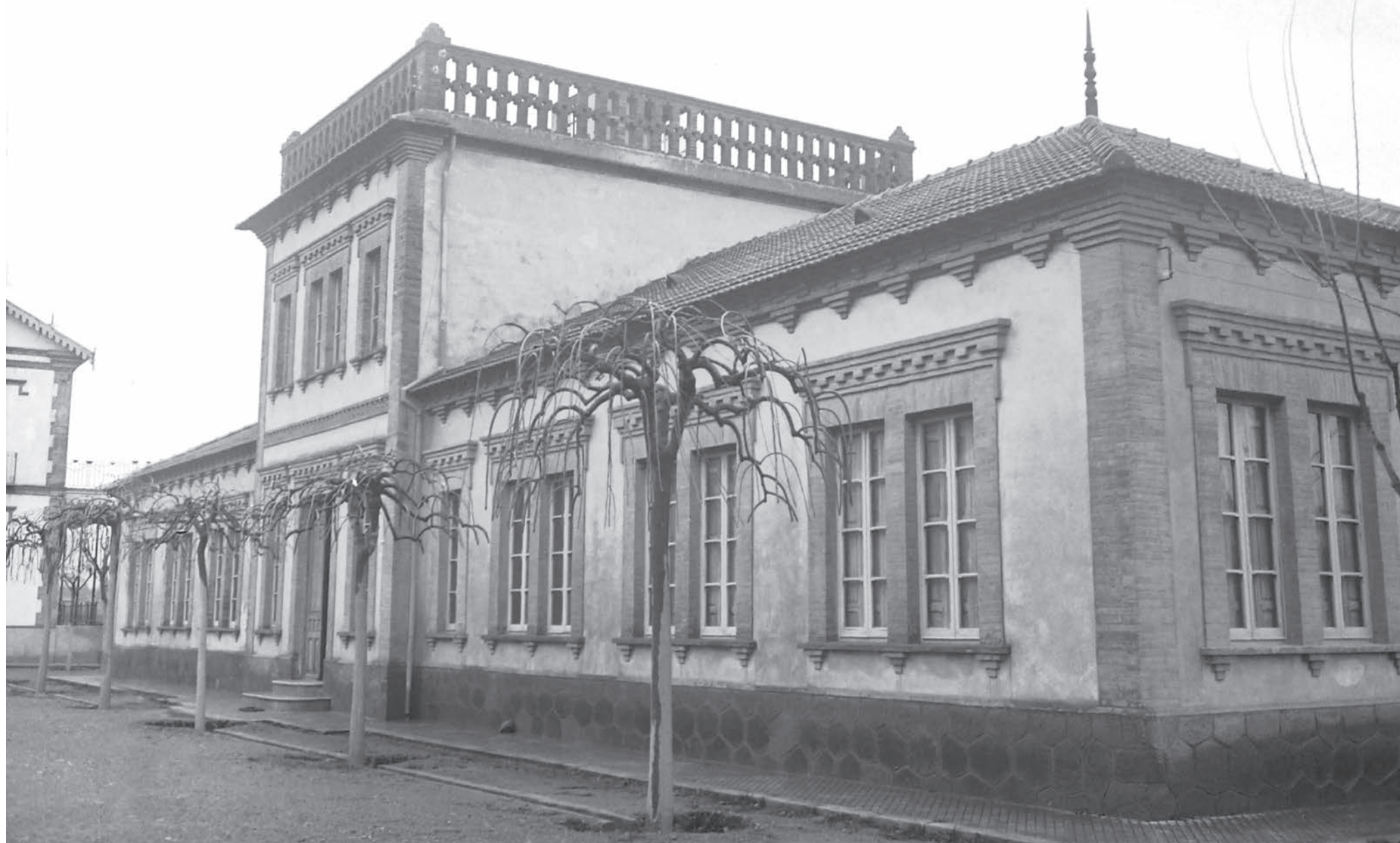
Fachada trasera del edificio de oficinas.
