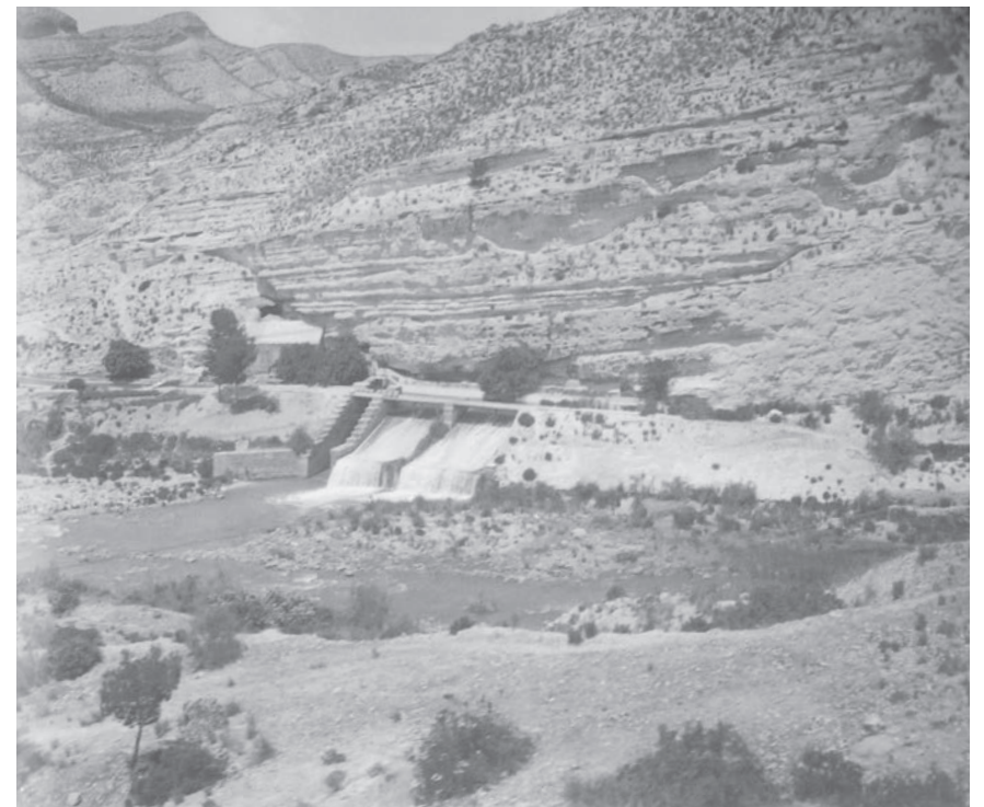
Azufrera del coto de Hellín (Albacete). Tramo regulador, con aliviadero de fondo y vertedero de superficie, con caseta del guarda a la izquierda. Se trata de mecanismos de regulación del caudal del río Mundo, con el fin de evitar sus catastróficas avenidas.
