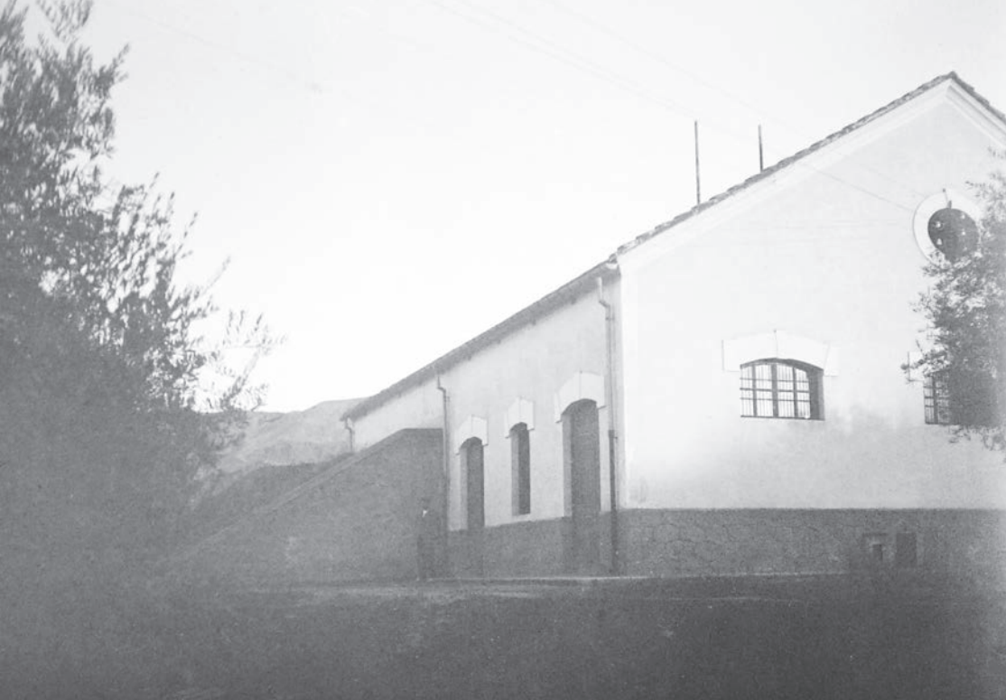
Fachada del edificio de la cámara frigorífica tras su inauguración en 1916.
