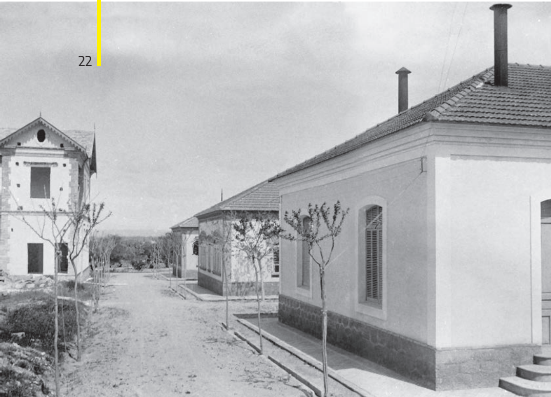
Vista de una de las calles entre los edificios principales.
