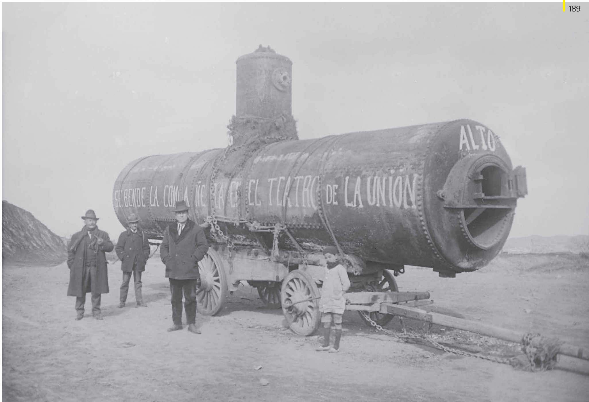
Momento del traslado de la caldera, en carreta, desde la mina hasta el ferrocarril, medio de transporte por el que llegaría a Murcia.
