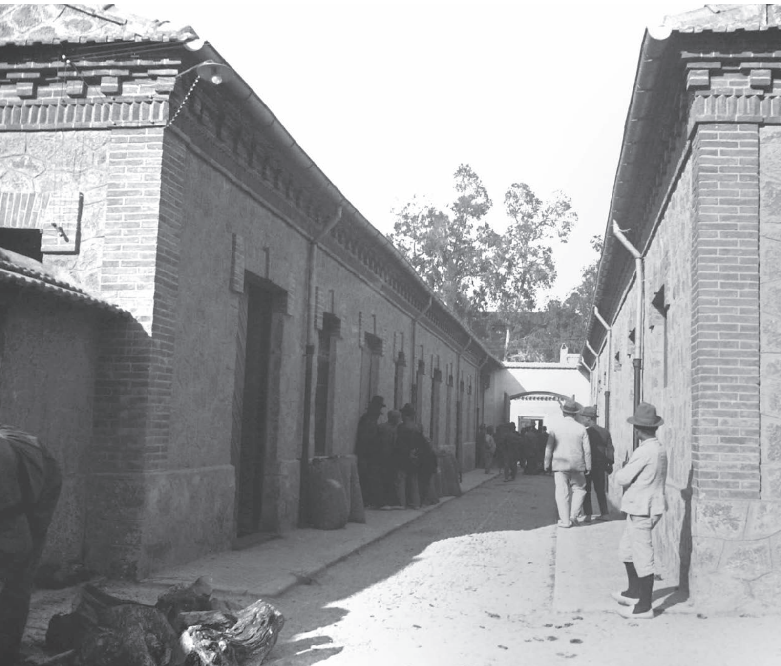
Interior del ahogadero secante de Ronda de Garay.
