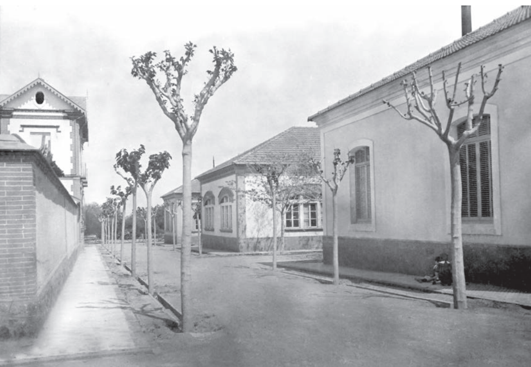
Misma vista años más tarde, con edificio y muro terminado y moreras más desarrolladas.
