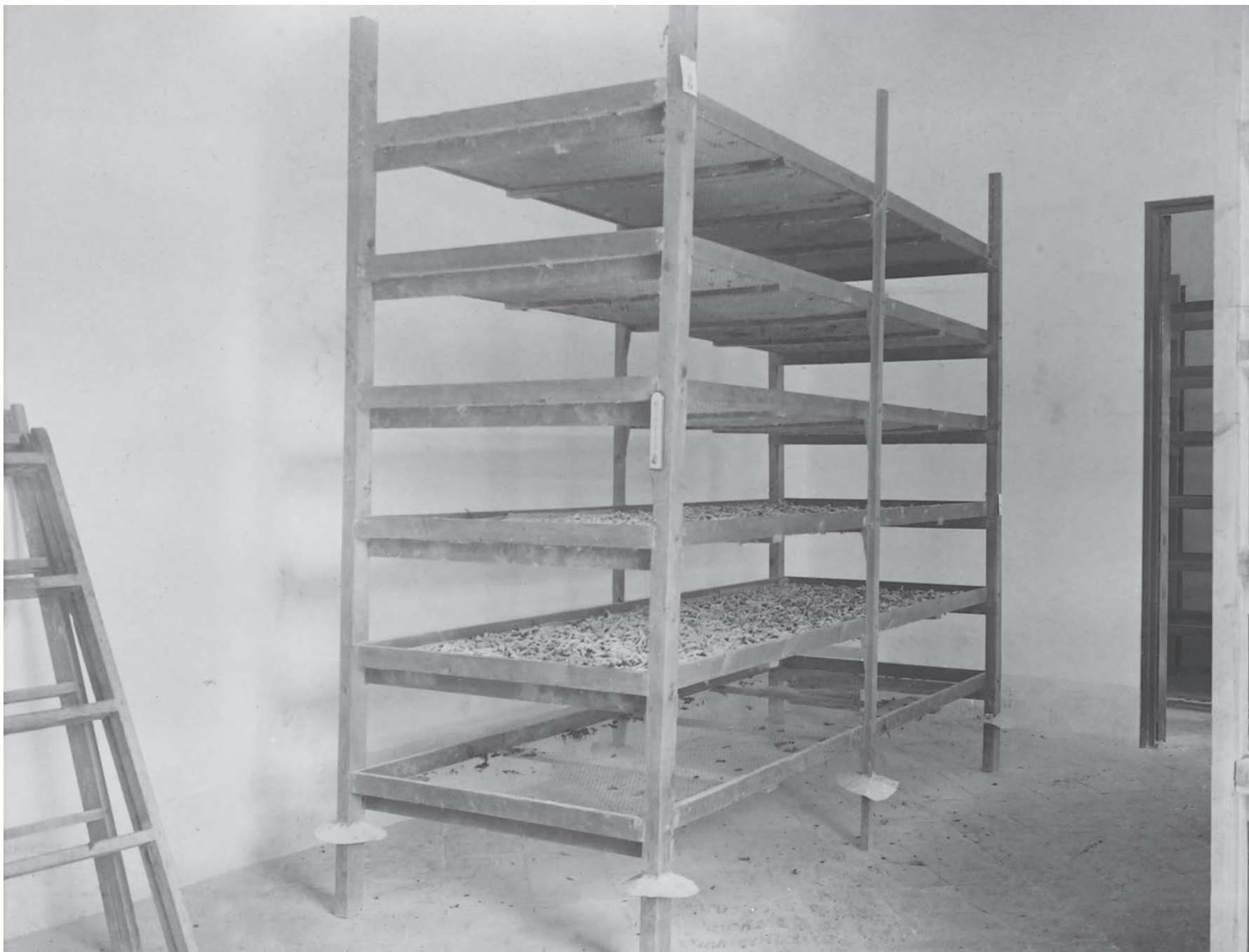
Andana tipo lombardo de seis zarzos, con protecciones de papel de estraza en las patas para evitar la subida de ratas y ratones. Longitud de zarzos: 3,20 x 1 metros. Distancia entre zarzos: 0,33 metros.
