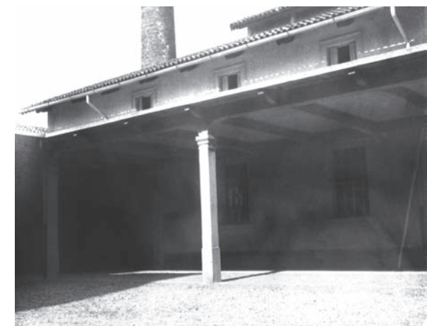
Patio interior del ahogadero secante.
